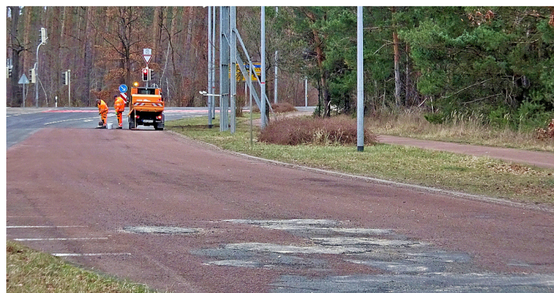
Der kommunale Eigenbetrieb von Oranienbaum-Wörlitz hat im Dessora-Park Schlaglöcher beseitigt. FOTO: ANDREAS BEHLING
