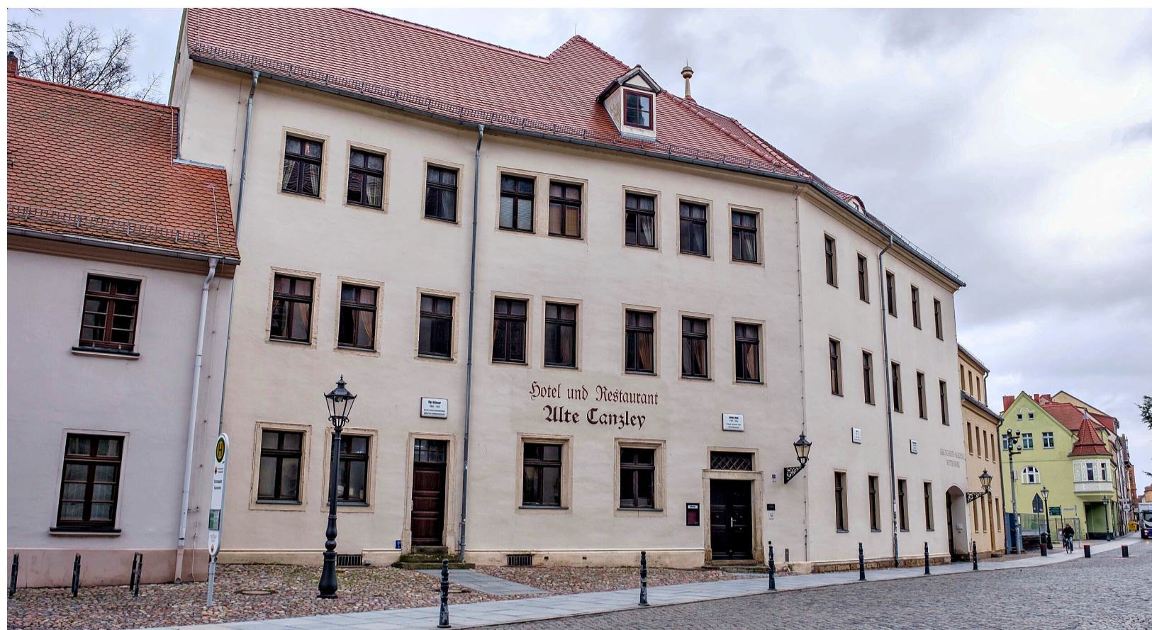
Seit Monaten ist die „Alte Canzley“ am Wittenberger Schlossplatz geschlossen, jetzt steht das Hotel zum Verkauf.
