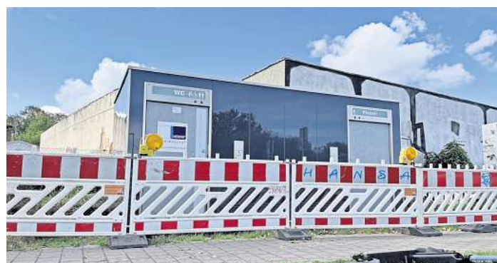
Dieses Toilettenhäuschen entsteht am Greifswalder Museumshafen. Bald soll es in Betrieb gehen.
